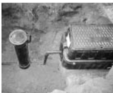
鉛製給水管の取替え工事が進められる
