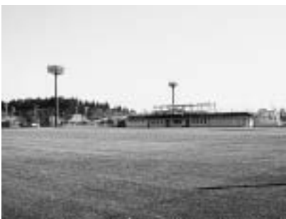
人口芝への全面改修を検討すべきでは(ツインフィールド)
