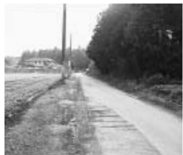
早急な整備が望まれる幹線市道10号線(吉沢元石川線)
