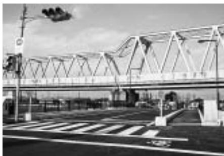
架け替え工事が完了した仲ノ橋
