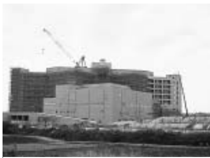
桜の郷事業の核となる建設中の国立水戸病院
