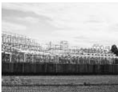
建設中の若宮保育所
